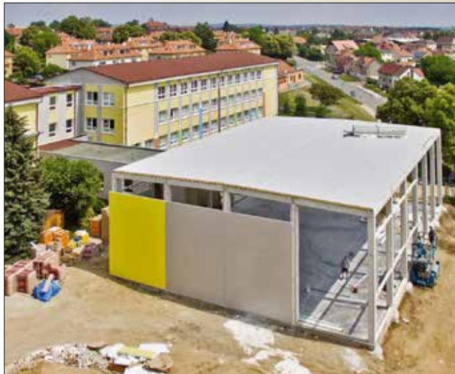
Výstavba nové tělocvičny
