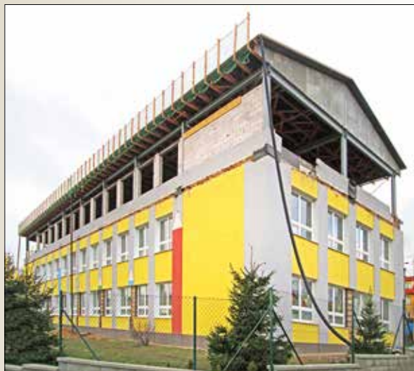
Stavba nástavby pavilonů
