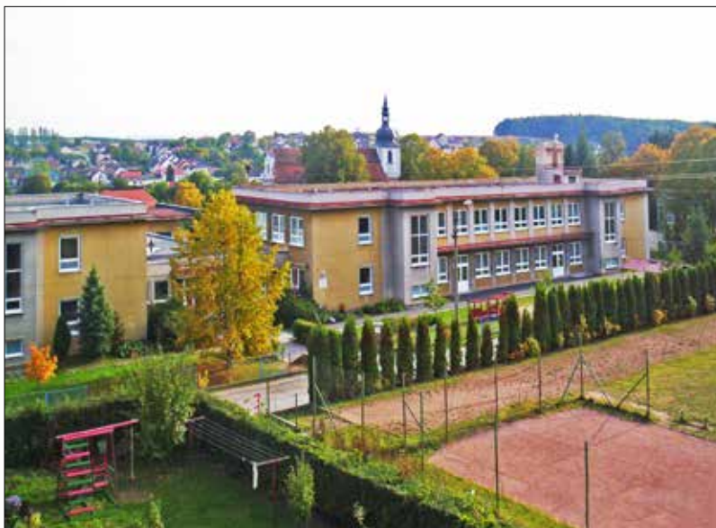
Budova školy s novými plastovými okny
