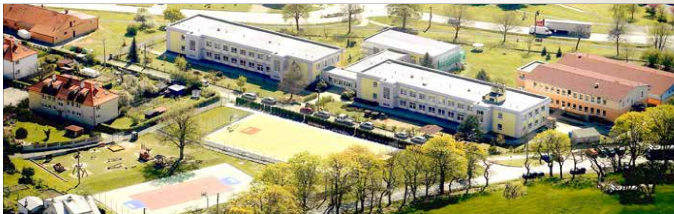
Škola s novou fasádou a sportovním areálem
